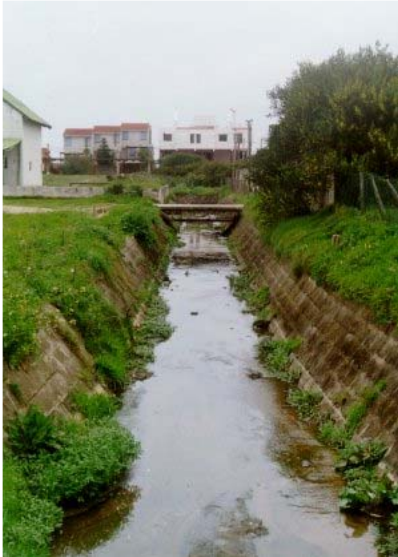
Figura 21. Otro ejemplo de la degradación de los pequeños sistemas de aguas corrientes. En este caso, la cañada ubicada en un sector densamente urbanizado de La Paloma, ha sido canalizada, perdiendo su capacidad de autodepuración y transformándose en un efluente que desemboca en un sector de playa de gran atractivo turístico (La Balconada).
